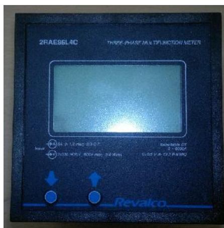
Figura 1.48 Central de Medida Digital (generador)
