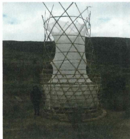
Colocación del plástico, sarán en la parte interna
