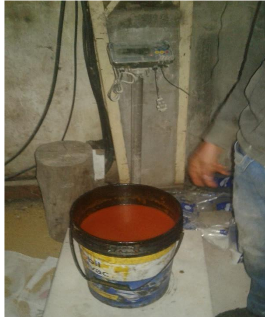
Comprobación del flujo impulsado por la bomba.
