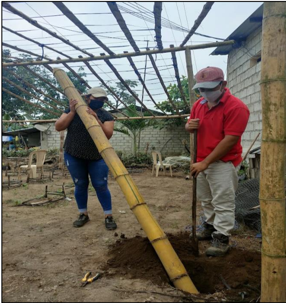
Fotografía 1. Construcción de la infraestructura
