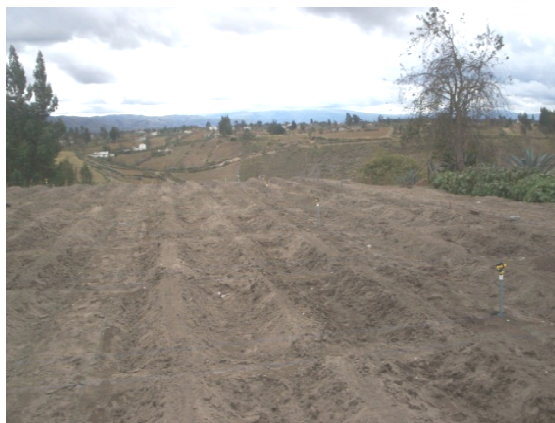
Foto 1. Preparación del terreno
