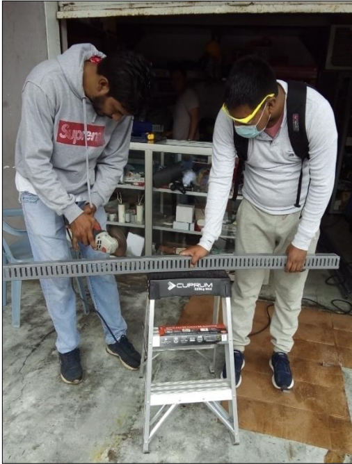
Fotografía 23. Cortes de canaletas ranuradas.
