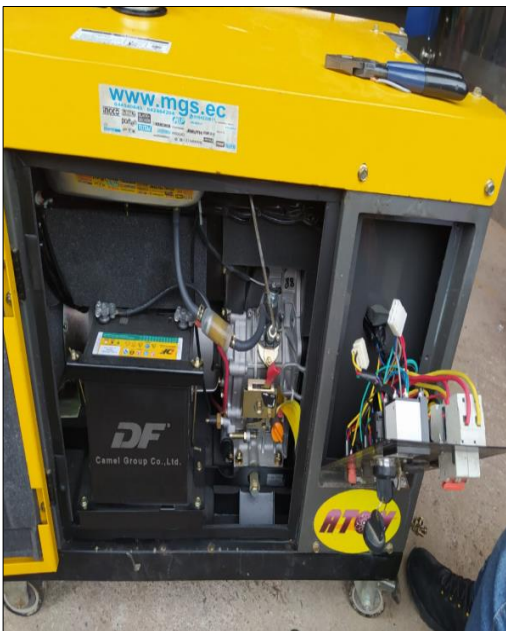
Fotografía 28. Instalación en el generador el circuito de mando.
