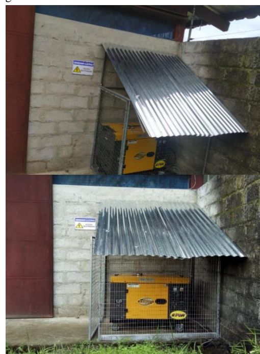
Fotografía 37. Finalización de la cubierta del generador.
