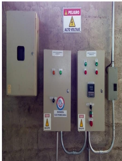
Fotografía 40. Finalización de los sistemas de secado automático.
