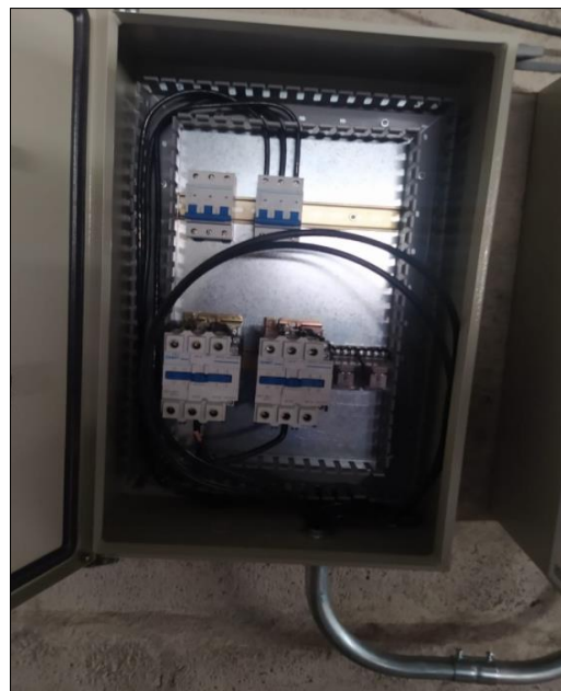
Fotografía 29. Instalación del circuito de fuerza en la transferencia automática.
