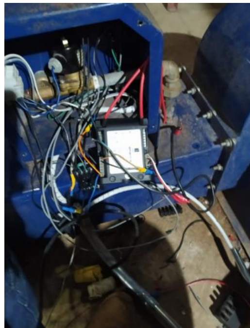
Fotografía 32. Instalación del control de llama.
