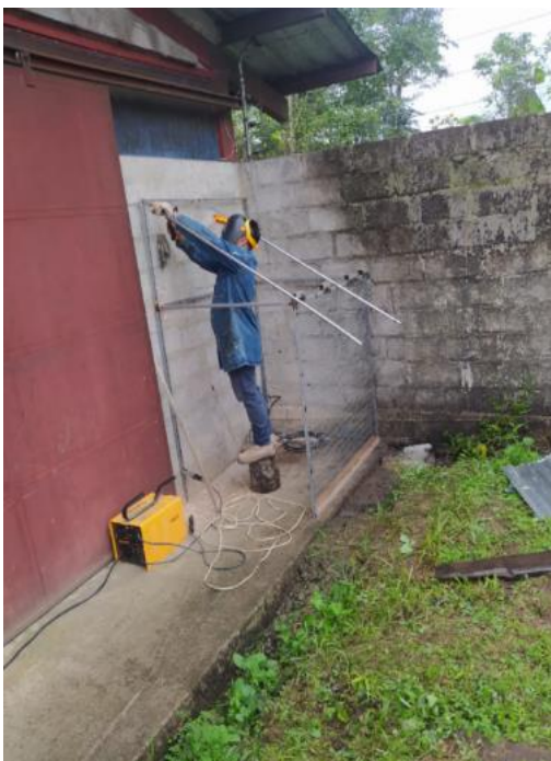
Fotografía 36. Soldadura del techo de la estructura.
