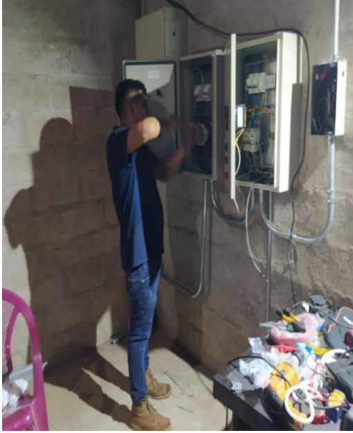
Fotografía 42. Instalación de los cables.
