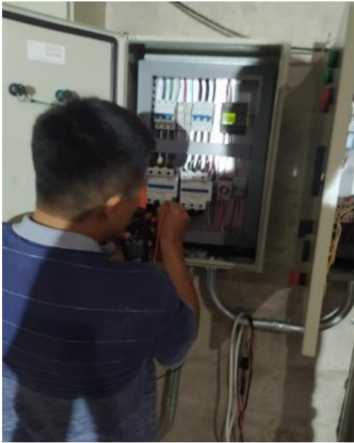
Fotografía 35. Medición de la tensión del sistema.
