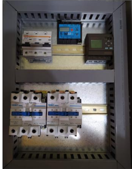
Fotografía 22. Instalación de los equipos.
