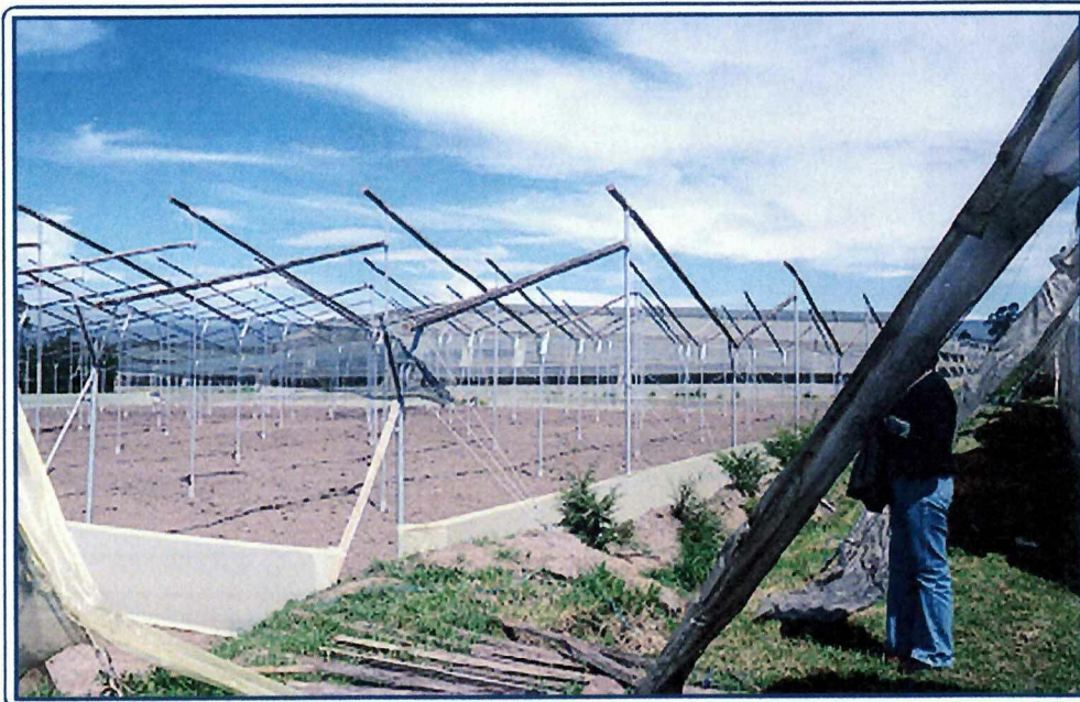
Fotografía 6. Nivelación del terreno e incorporación del sistema de riego
