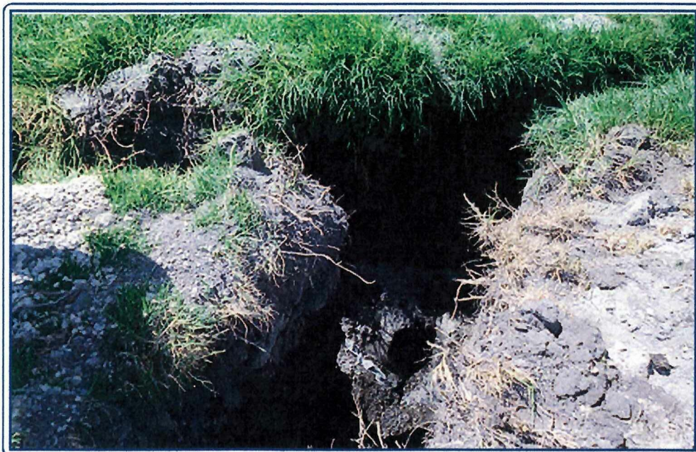
Fotografía 2. Ubicación de tuberías en las zonas de drenaje
