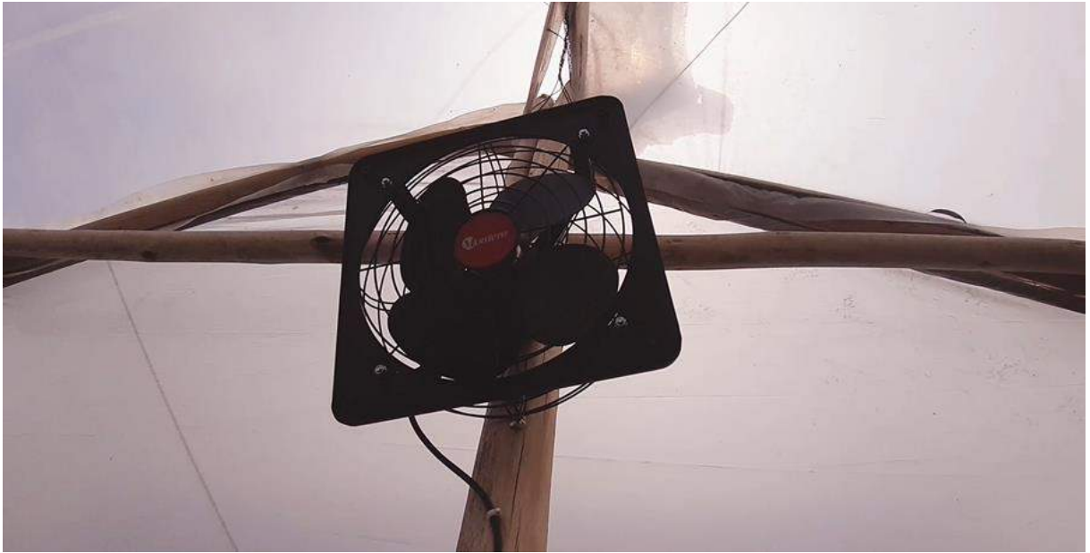
Figura C.3. Instalación del extractor de aire montero
