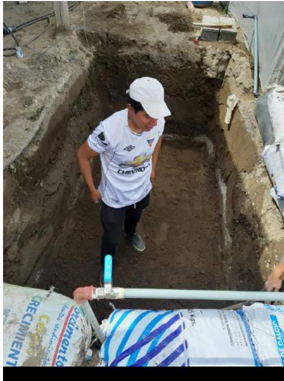
Figura B.5. Adecuación del reservorio de agua para el sistema de riego
