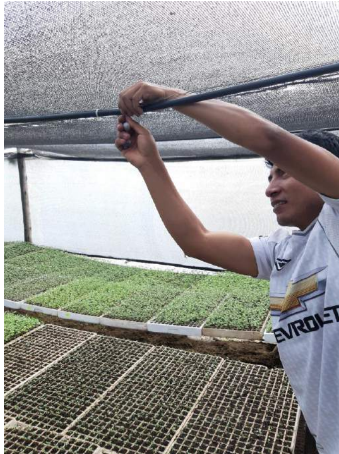
Figura B.7. Instalación del sistema de riego por microaspersores
