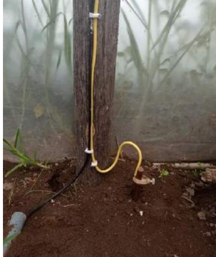
Figura 5.9. Instalación del sistema de puesta a tierra
