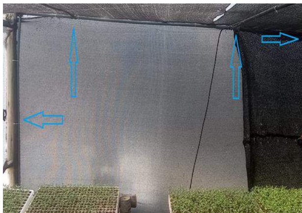
Figura 5.4. Distribución de TUB EC 25mm a lo largo del Invernadero
