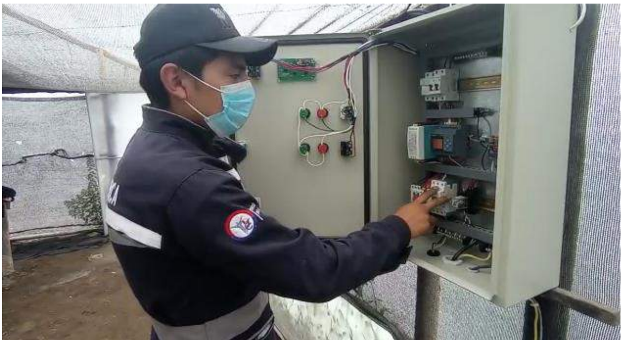
Figura D.4. Ubicación del tablero de control en el invernadero
