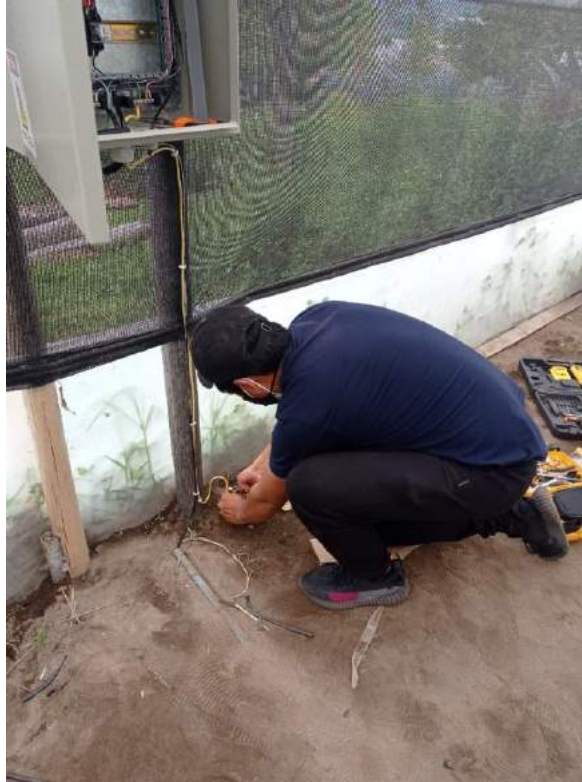
Figura D.5. Instalación de la puesta a tierra del tablero de control
