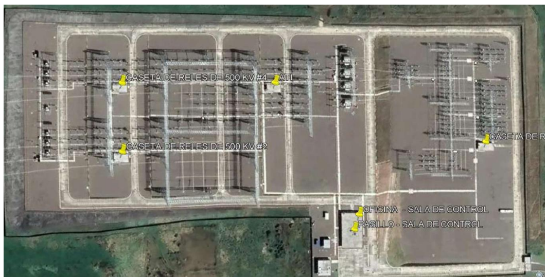
Figura 22. Puntos de medición, tercera etapa – vista general Subestación Tisaleo. Fuente: Autor
