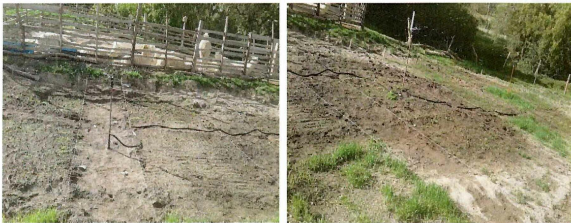
Fotografía 5. Instalación de Riego
