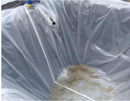
Figura 28. Extensión del reservorio
