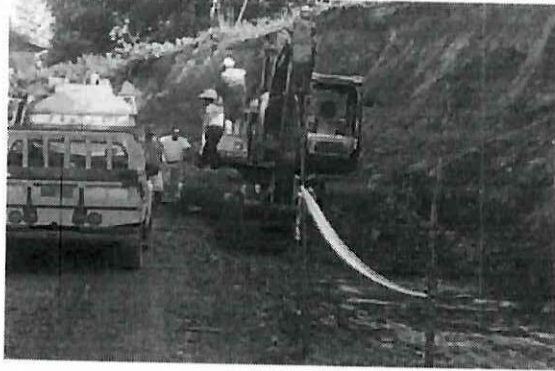
GRÁFICO 1.4. MEJORAMIENTO Y COLOCACIÓN DE CAPA DE RODADURA CON DOBLE TRATAMIENTO SUPERFICIAL BITUMINOSO EN CARRETERAS PUERTO NAPO – MISAHUALLI, PUERTO NAPO - ARAJUNO, TENA – TALAG, TENA – MUYUNA – ATACAPI, ARCHIDONA – SAN PABLO
