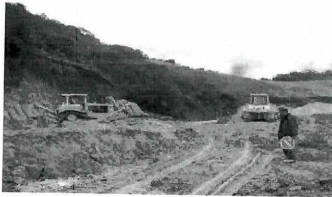
GRAFICO 1.3. CONSTRUCCIÓN DE LA CARRETERA MATRAMA - PINDILIG – RIVERA – MAZAR
