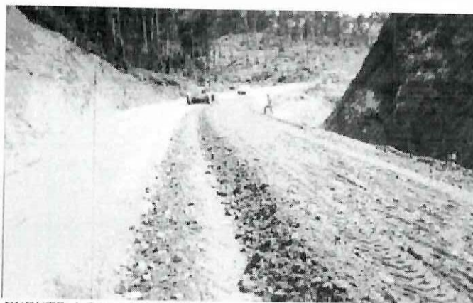
GRAFICO 1.1. MANTENIMIENTO DE VÍAS Y PLATAFORMAS DE LOS CAMPOS LAGO AGRIO Y SHUSHUFINDI EN LA ZONA 1
