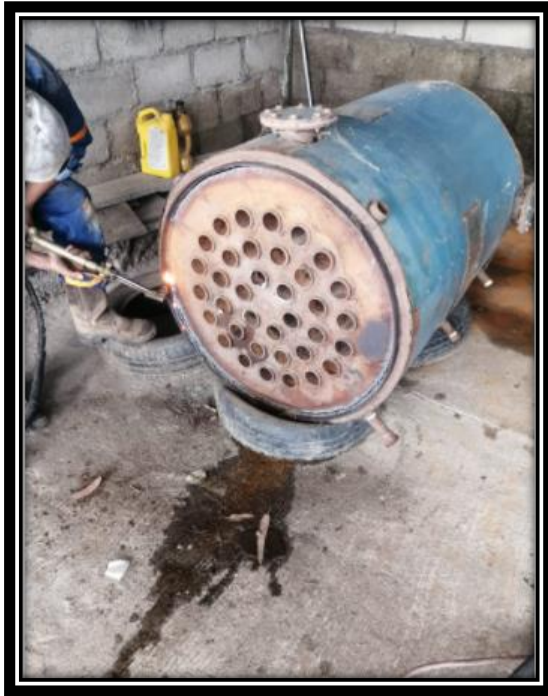
Figura VII-4 Mantenimiento correctivo de la caldera Fuente: [1]
