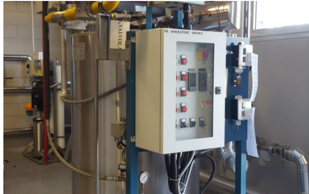
Figura 3-4 Tablero de control PID Fuente: [17]
