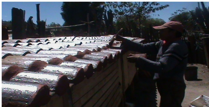
Fotografía N° 7 Colocación de pigmento en las tejas
