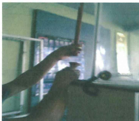
FIGURA 3.41 DESMONTAJE DE LAS RESERVAS
