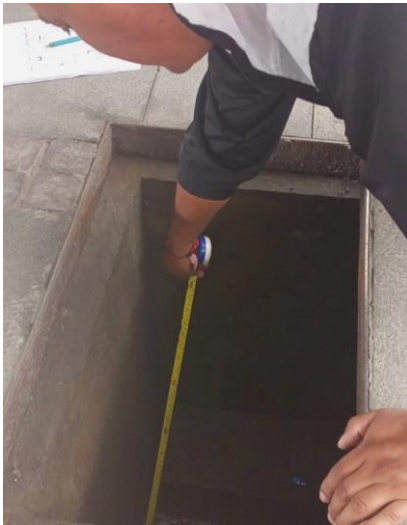
Figura 25. Verificación de la caja de revisión del Bloque B y del sentido del flujo de aguas lluvias.
