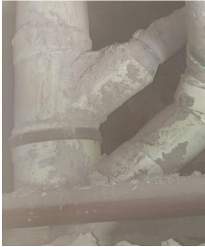
Figura 23. Inspección de las conexiones y tuberías de aguas sanitarias.
