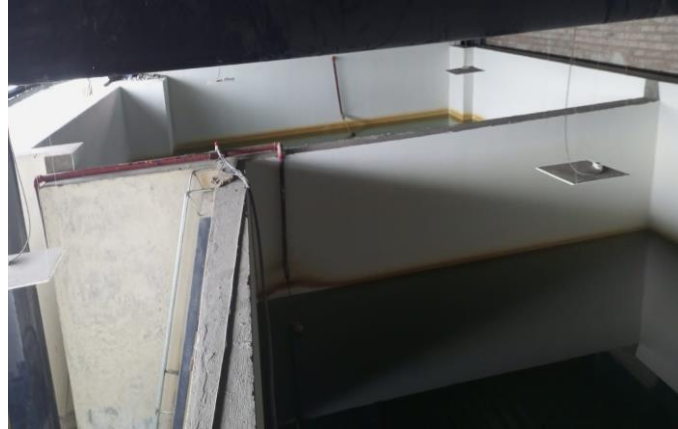
Figura 10. Levantamiento de información de tanques cisternas.
