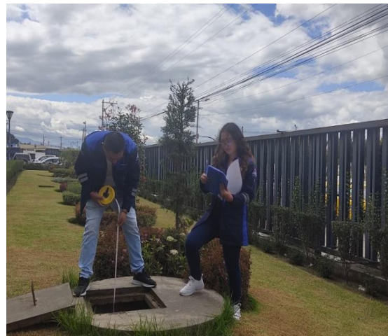
Figura 26. Levantamiento de información de las redes sanitarias: se observa un pozo de alcantarillado en la salida principal del Edificio A.
