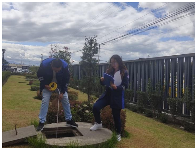
Figura 11. Comprobación llevada a cabo en el pozo de alcantarilla del bloque A que conecta al colector de la red municipal.
