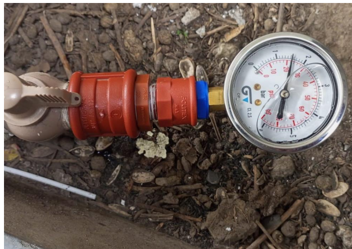
Figura 9. Comprobación de presión en jardineras del cuarto piso, Bloque A (30 PSI promedio).
