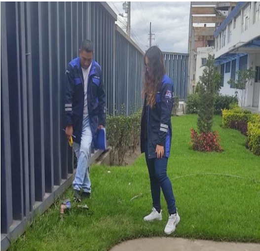
Figura 17. Se observan fugas de agua en el jardín frontal de la universidad debido al deterioro de los accesorios.
