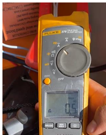
Figura 47. Medición de la corriente AC consumida por la carga.
