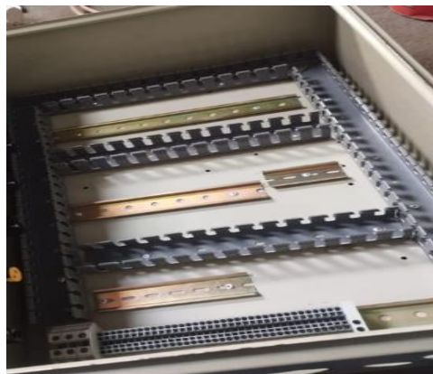
Figura 4.33. Colocación de canaletas y riel din en nuestro tablero de distribución.
