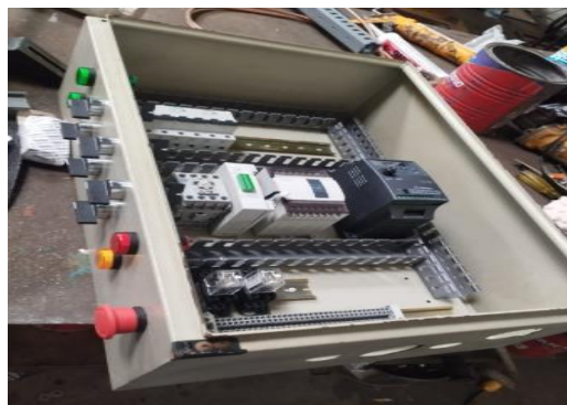
Figura 4.34. Incorporación de los elementos eléctricos.
