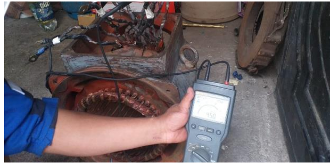
Figura IX.3 Aislamiento de la carcasa del generador
