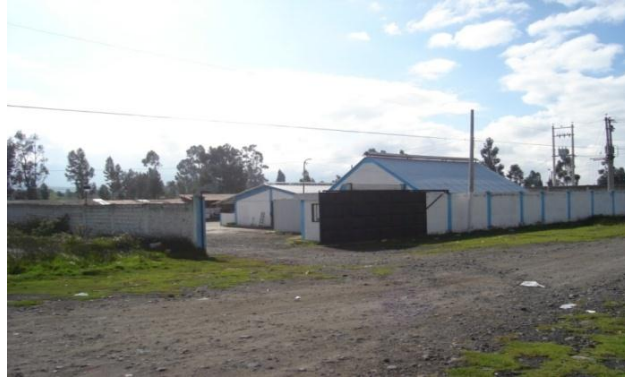
Fig. N° 21: EMPRESA MOLIDESA S.A. (VISTA FRONTAL)
