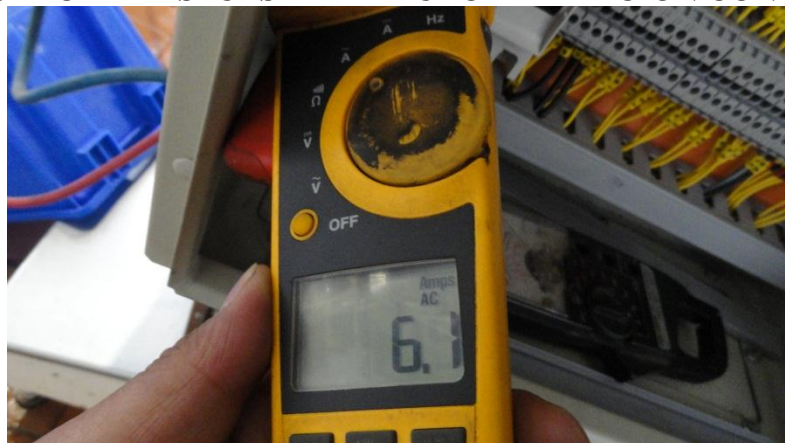
Fig. N° 52: MEDICIÓN DE LA CORRIENTE DE CONSUMO EN LA ENVASADORA DESPUÉS DE LA AUTOMATIZACIÓN CON EL PLC
