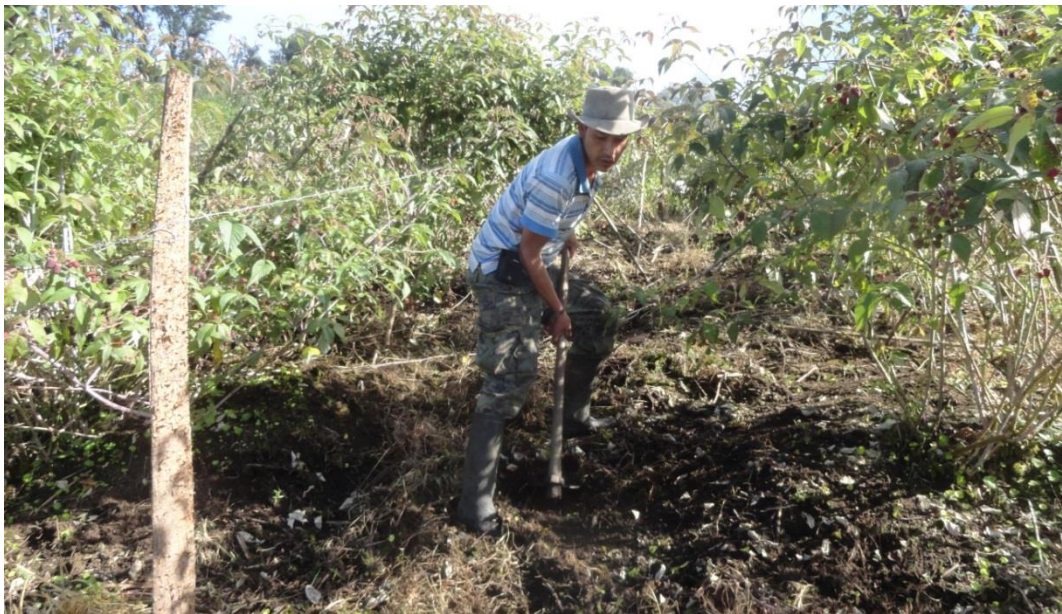
Foto 1. Limpieza del terreno
