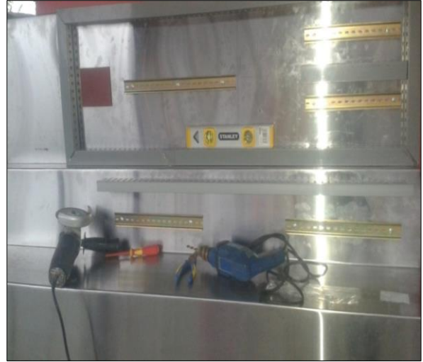
Instalación de canaletas y distribución
