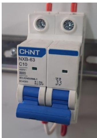
Figura 17. Breaker 2 polos
