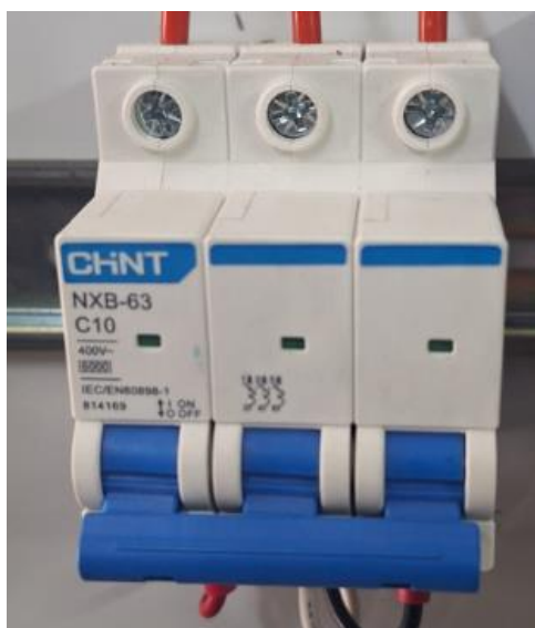
Figura 18. Breaker 3 polos
