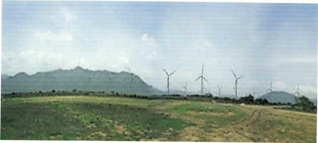
Central eoloeléctrica "La venta" ubicada en Oaxaca, México.
