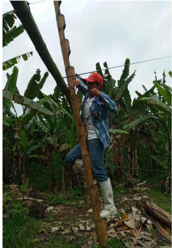
Fotografía 2. Construcción de la cubierta plástica
