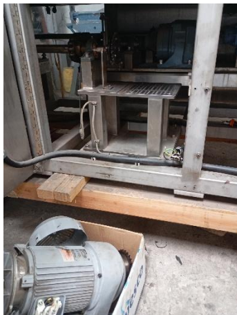
Figura A. 7 Desinstalación de motor para mantenimiento
