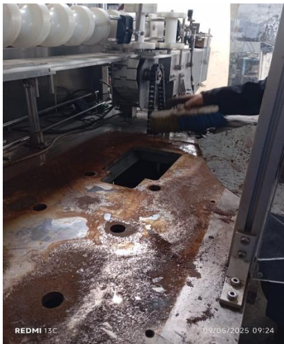
Figura A. 3 Sistema de tapado con presencia de óxido
