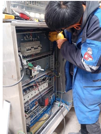
Figura A. 5 Instalación de Variador de frecuencia
