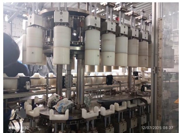
Figura A. 15 Instalación de cabezales de tapado.
