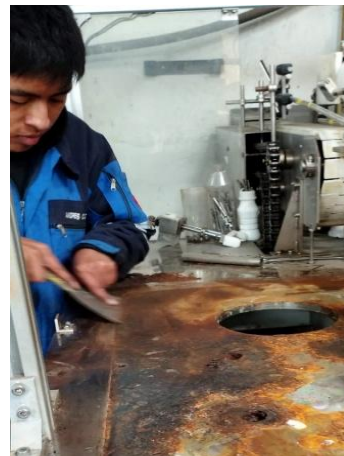
Figura A. 8 Remoción de óxido de la base del sistema de tapado.
