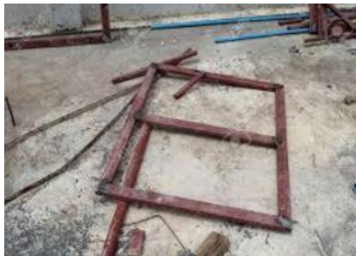
Figura 3.6. Proceso armado de estructura
