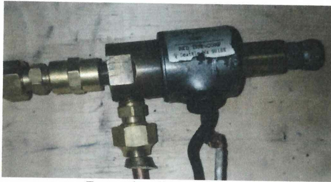
FIGURA N° 3.17. VÁLVULAS SOLENOIDE
