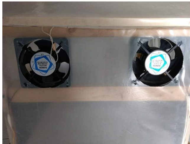
Figura 6. 14. Ubicación de los ventiladores en el invernadero.
