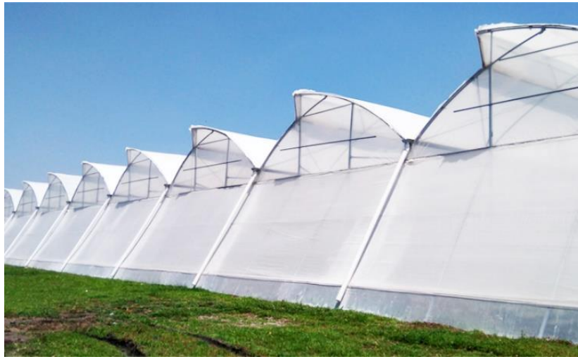
Figura 3.6. Invernadero tipo asimétrico.
