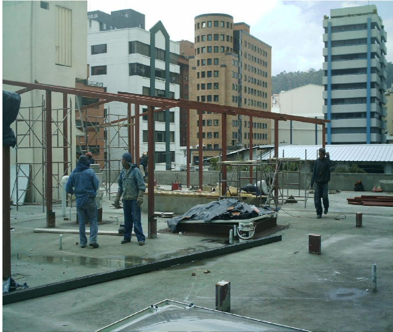
Figura No.23 Construcción último piso Hotel Finlandia
