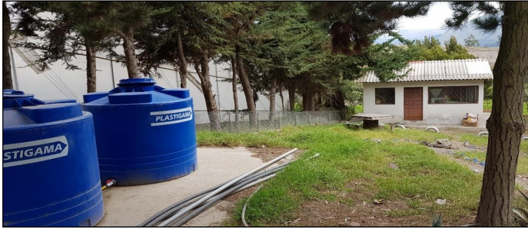
Figura 4.6: Excavación de la zanja
