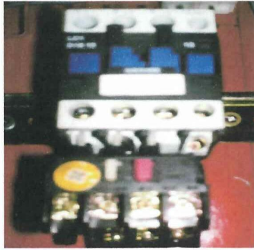
FÍGURA.Nº 37: Guarda motor. Fuente: Realizada por el investigador
