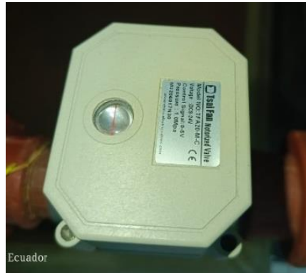
Figura 4.4 Válvula proporcional 0-5V 2 vías Modelo TFA20-M-C.
