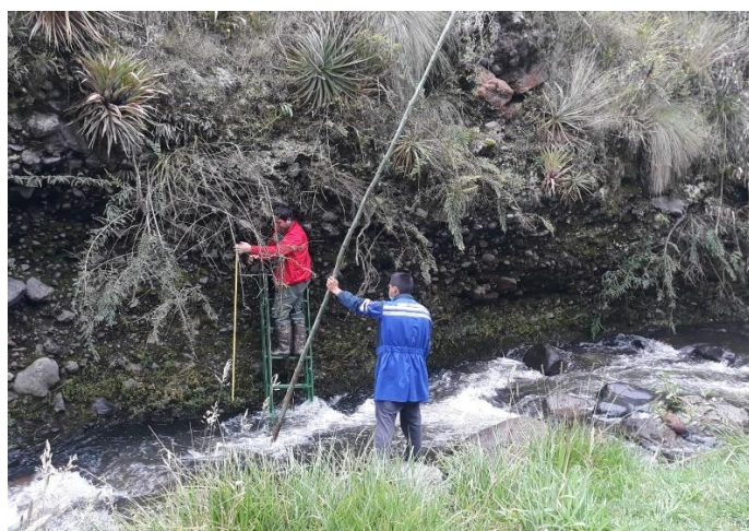
Figura 4.3. Visita de campo e inspección en el sector del Río Illuchi.
