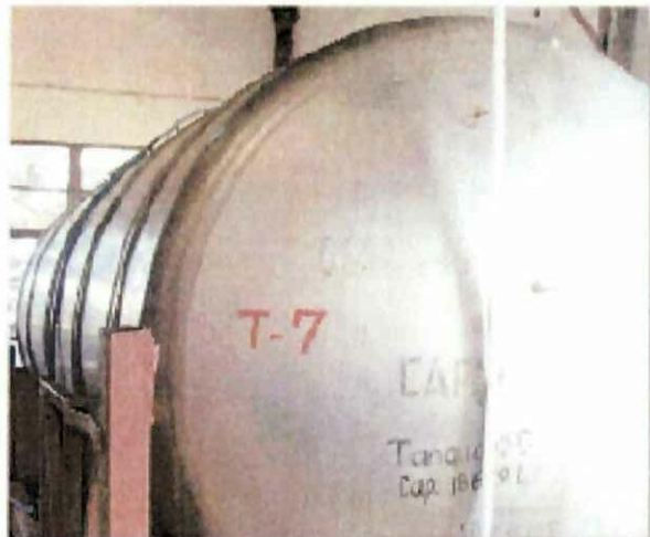
Tanque donde se prepara la maceración
