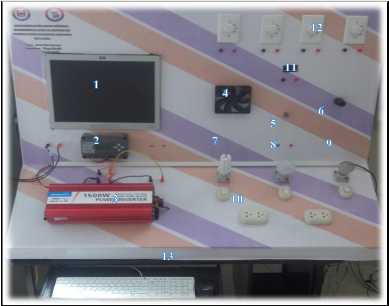
Figura 5.20. Tablero principal y las partes que lo componen
