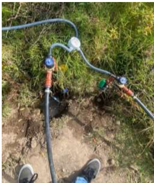
Figura 25. Implementación de conexión y manguera de aspersores
