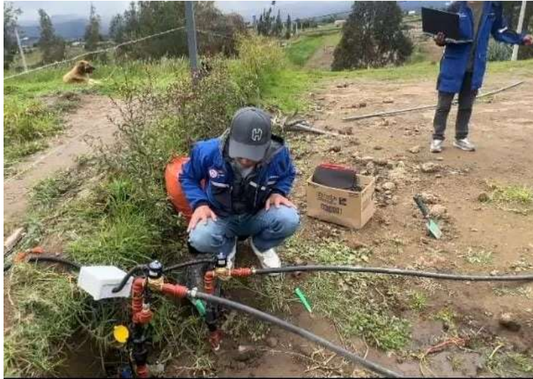
Figura 22. Verificación de fugas y funcionamiento en electroválvulas
