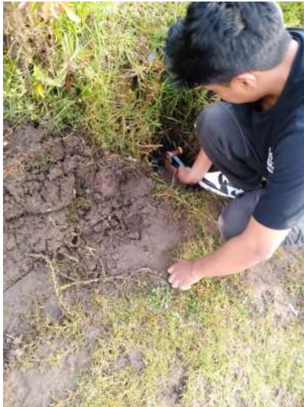
Figura 24. Instalación de tubería para la tercera Electroválvula
