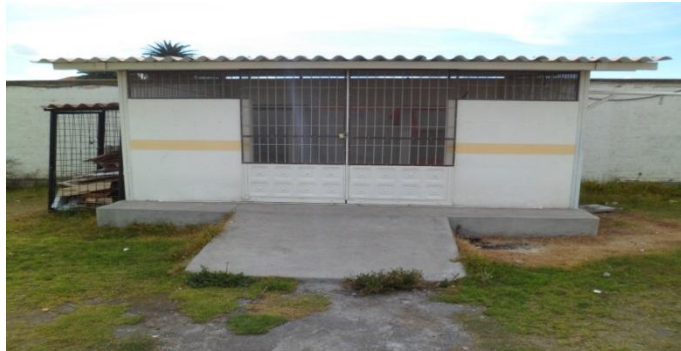
FOTO N° 12 CENTRO DE ACOPIO
