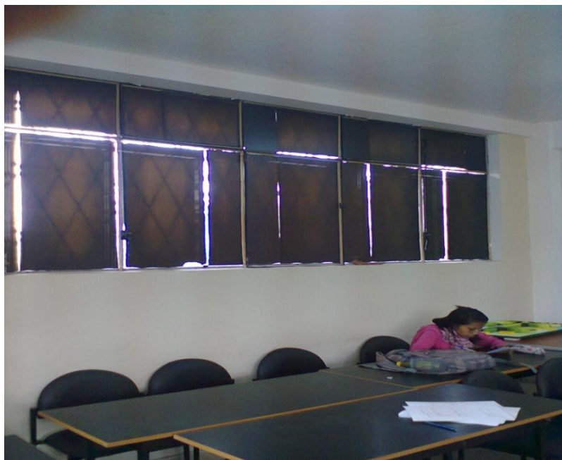
Figura 3.4 Polarización de Ventanas.
