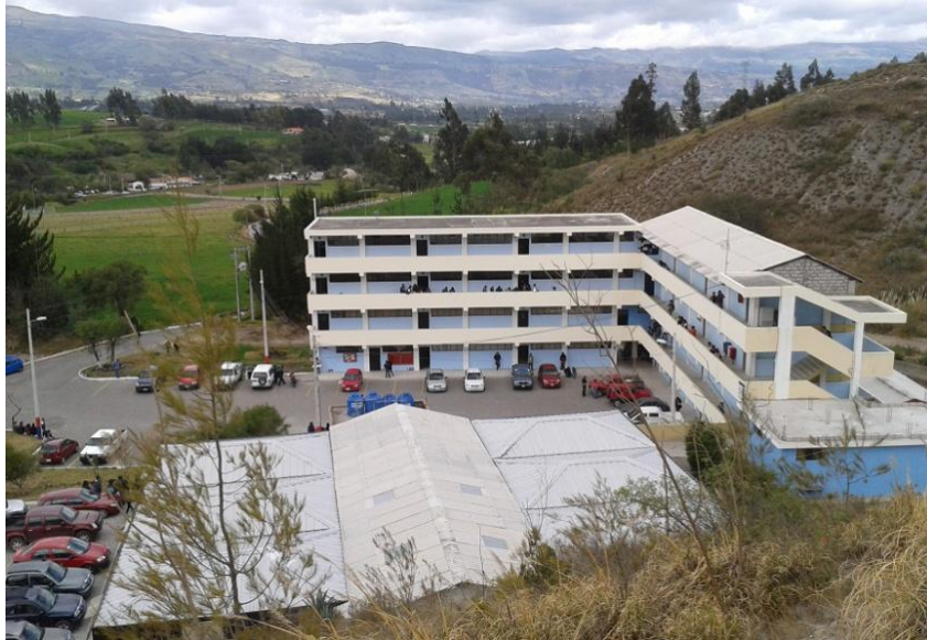
Figura 3.3. Edificación de la Unidad académica de CAREN
