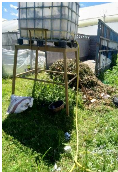
Figura 46. Estado de tanque
