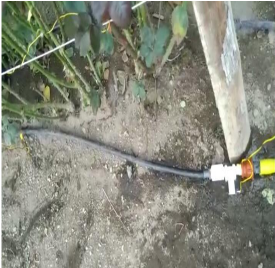
Figura 57. Activación por electroválvula
