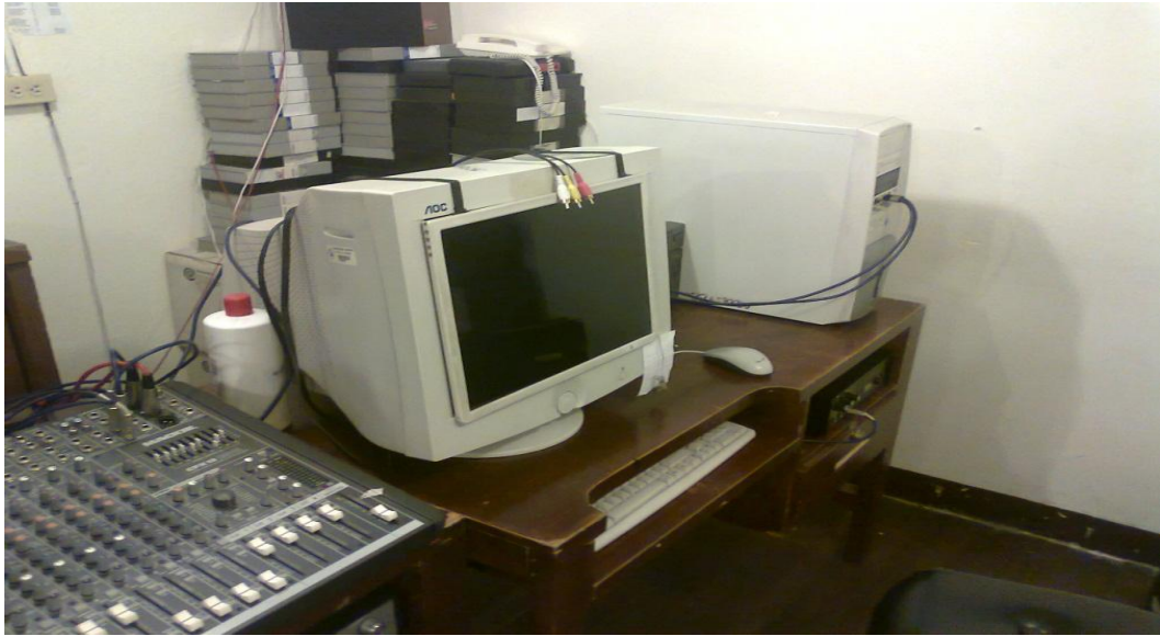
Control máster de la U.C.E.
