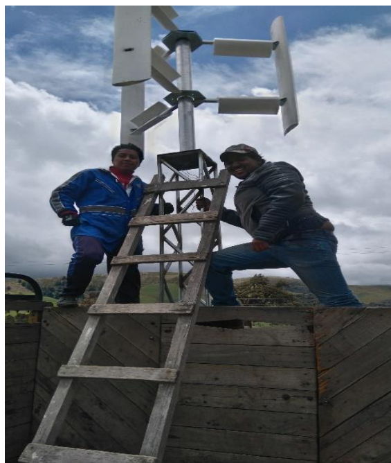
Figura14. Instalación del aerogenerador y torre
