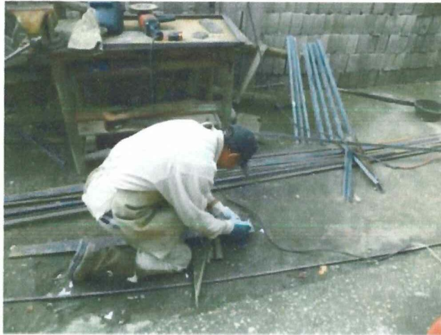
Figura 3.1. Elementos para la construcción
