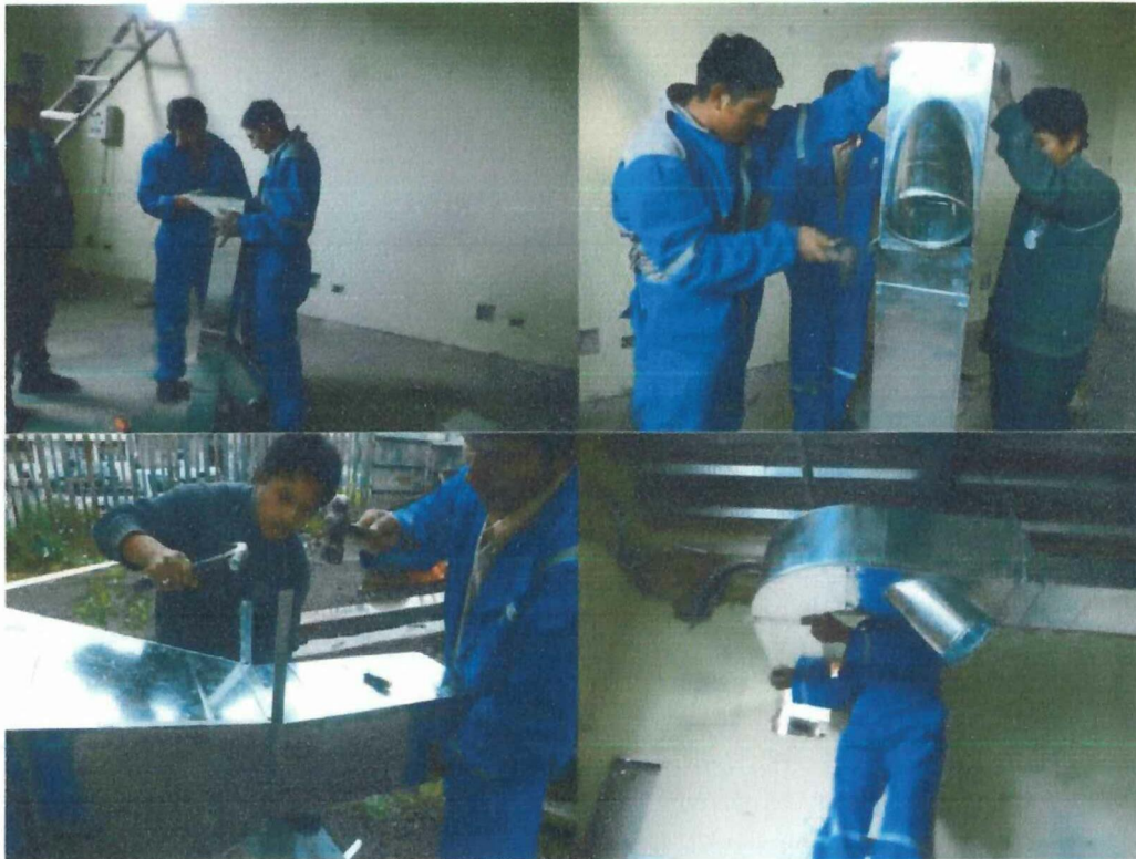
Figura 3.5. Ensamble del sistema de extracción de gases
