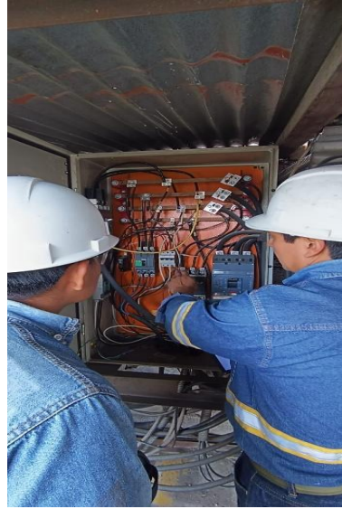
Figura 4.10 Inspección visual del tablero (TP-B)
