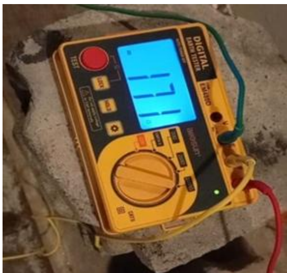
Figura 5.19 Medición de la resistencia del SPT en la planta matriz INDUACERO.
