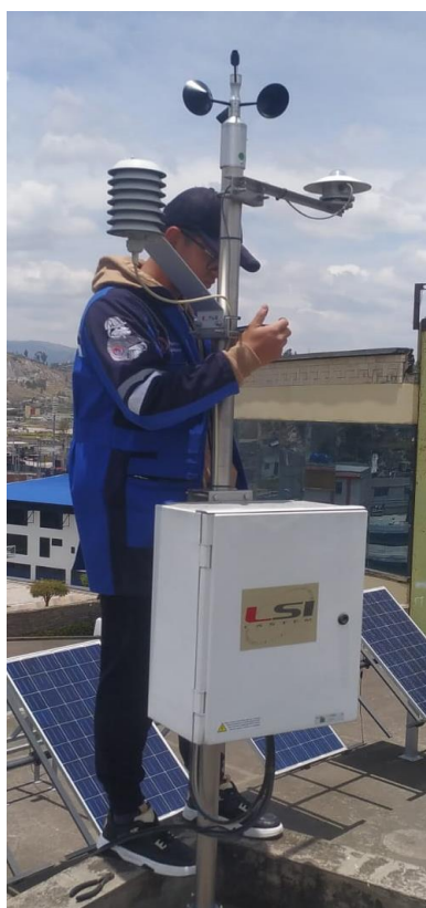
Figura 18: Montaje del sensor apuntando al norte verdadero (geográfico).
