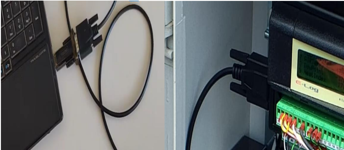
Figura 4.9 Cable RS232 conectado al E-log y en el ordenador para adquisición de datos.
