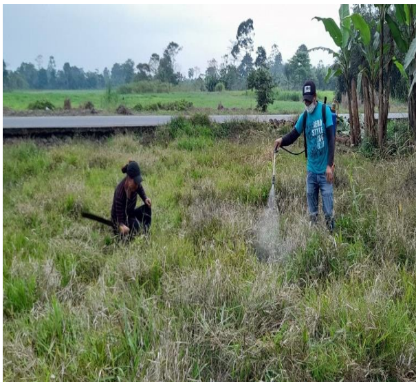
Fotografía 1: Limpieza del terreno.
