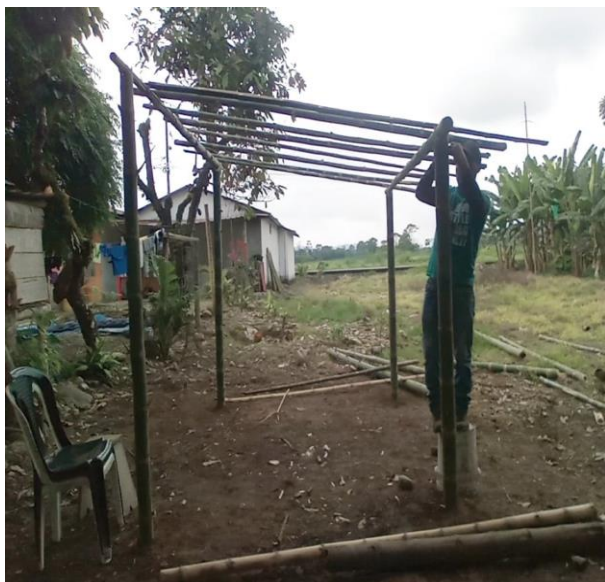
Fotografía 3: Construcción del semillero
