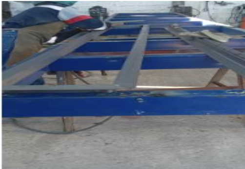
Figura 5.9. Verificación de material
