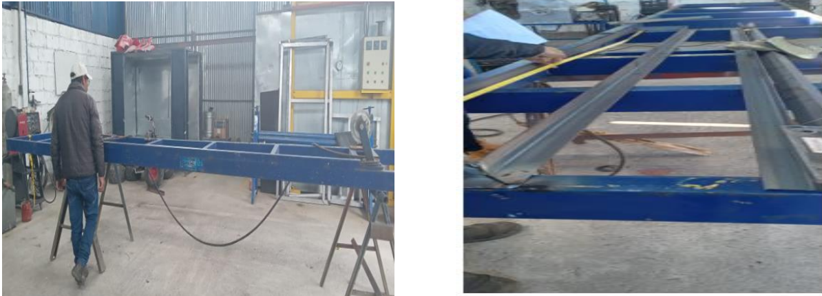
Figura 5.5. Toma de medidas
