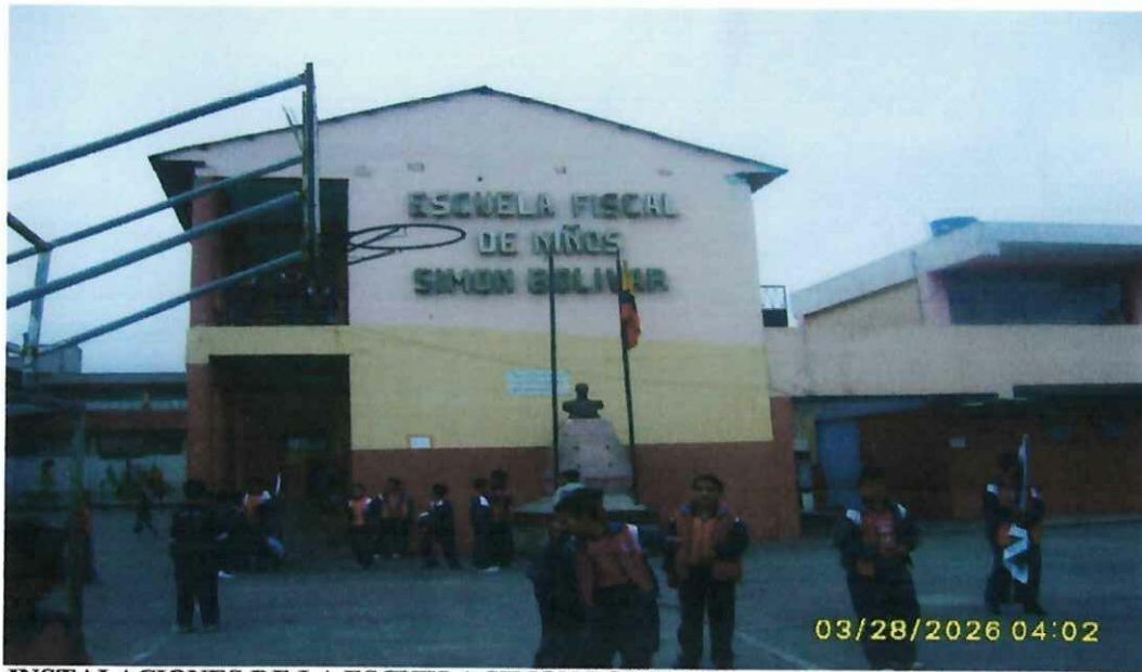
INSTALACIONES DE LA ESCUELA SIMÓN BOLÍVAR
