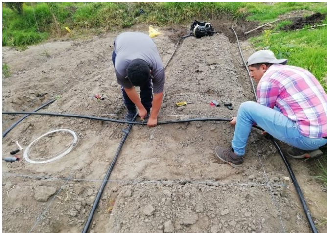
Anexo N 1 Instalación del sistema de riego
