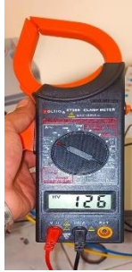
Figura 51 Voltaje de salida del inversor
